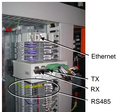
Abbildung 4.17 Klemmen der seriellen Schnittstellen
