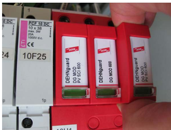
Abbildung 6.5 Austausch einer defekten Überspannungsschutzsicherung
