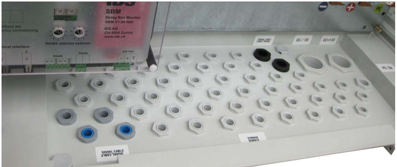
Abbildung 5.6 Kabeldurchführungen der SOLO String Box (Innenansicht)
