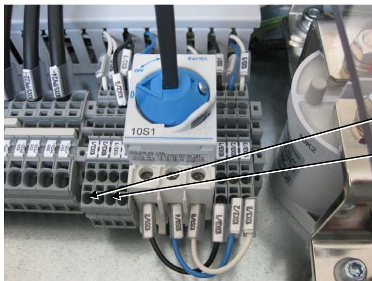
Abbildung 5.15 Anschlüsse für die Schützenansteuerung und die Bereitschafts-Rückmeldesignale
