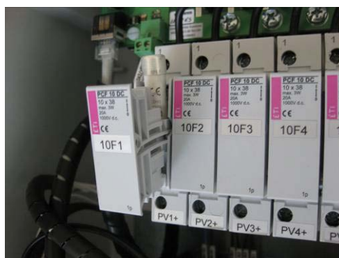
Abbildung 6.3 Geöffneter Sicherungshalters
